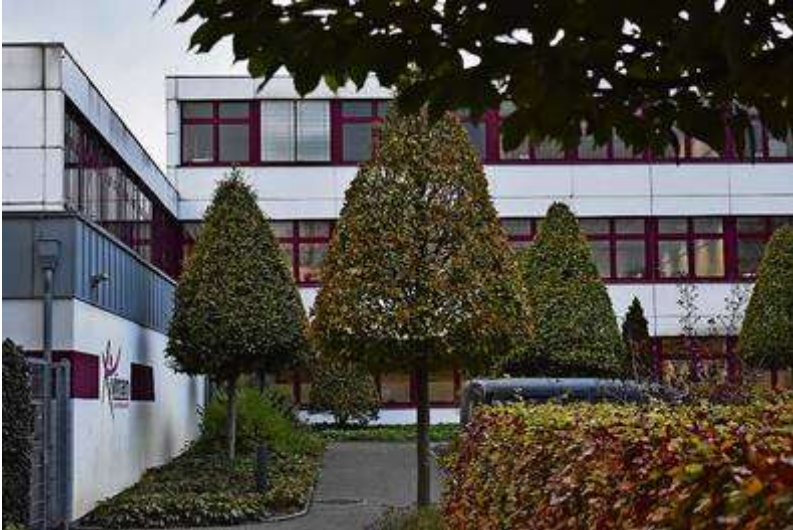
Im Januar beginnen die Arbeiten für das provisorische Oberstufenhaus an der BBS in Zeven. Hennings
